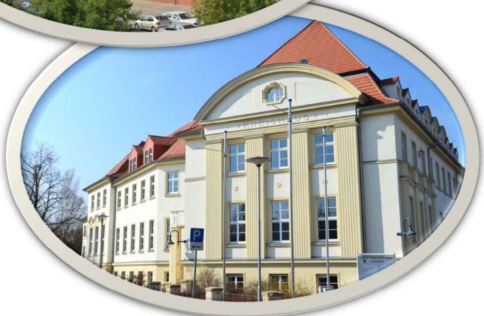
Verwaltungsgebäude beider Landkreise
