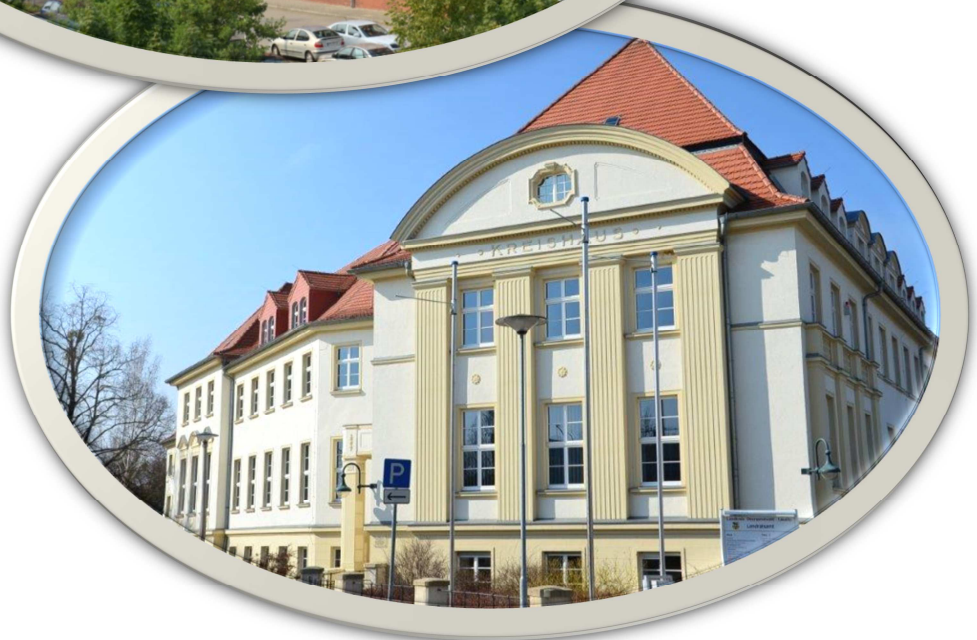
Verwaltungsgebäude beider Landkreise
