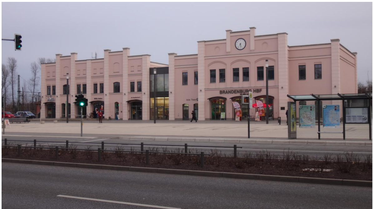
Blick auf den neu gestalteten Hauptbahnhof in Brandenburg an der Havel
