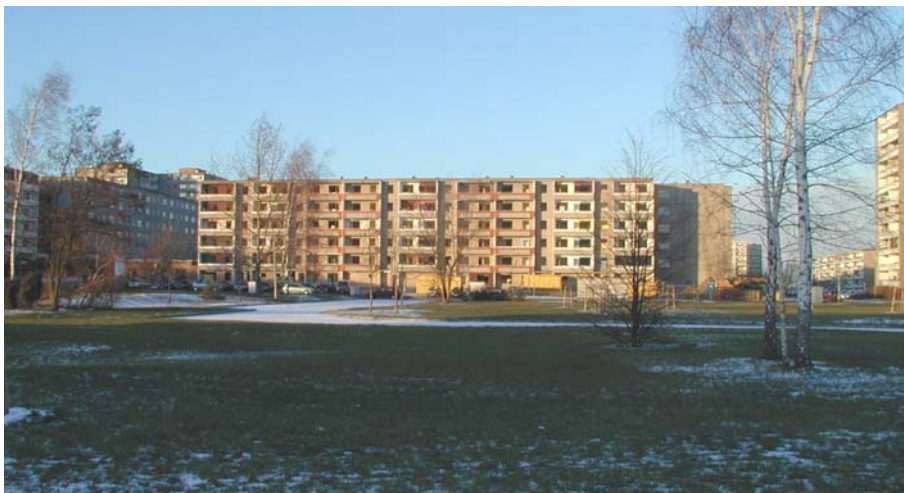
Abb.: Zustand des Wohngebietes zum 01.01.2004
